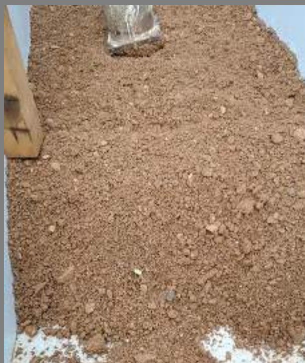
SUCCESSIVE COMPATTAZIONI MECCANICHE (strato compattato 7cm)
