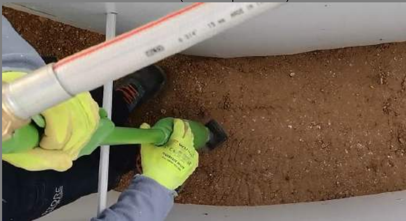
SUCCESSIVE COMPATTAZIONI MECCANICHE (strato compattato 7cm)
