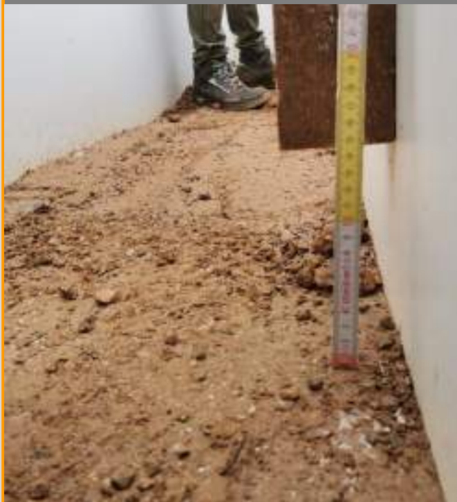
SUCCESSIVE COMPATTAZIONI MECCANICHE (strato compattato 7cm)
